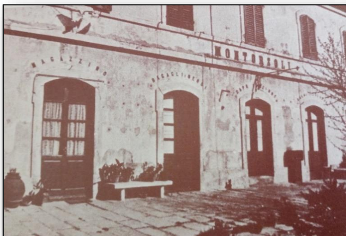
La stazione di Montorsoli luogo dell'attacco del 4 aprile 1944
